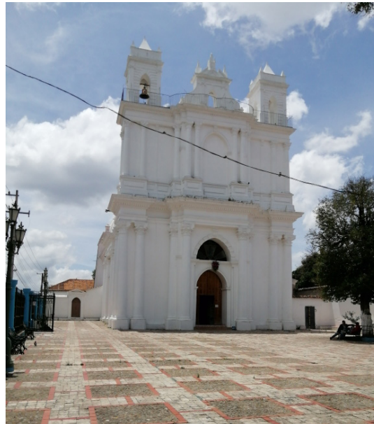
Figura 2. Iglesia de Santa Lucía, reparada después del terremoto de 2017.
